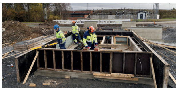
Ultrakondensaattorin perustuksia rakennettiin syksyllä.
